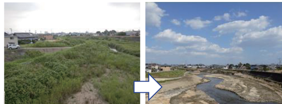
河川の堆積土砂撤去
